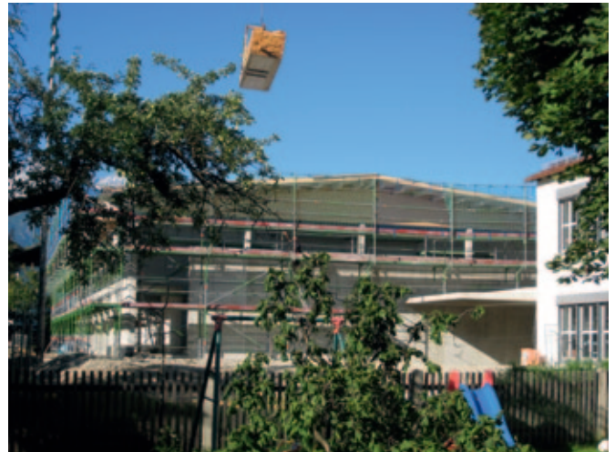
Foto: Baufortschritt Turnhalle
