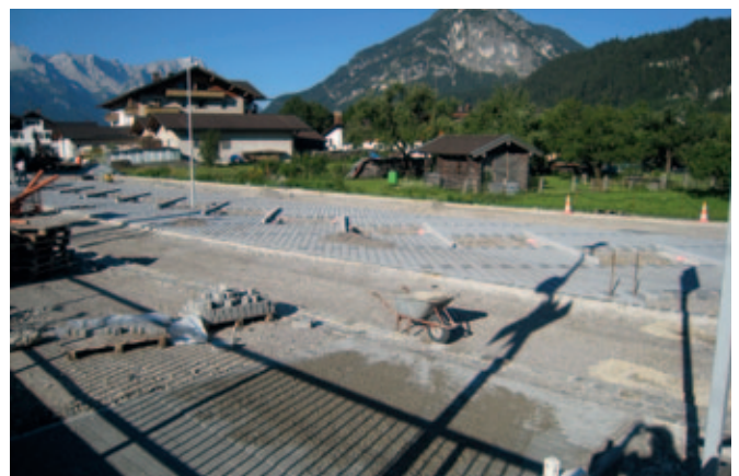
Foto: Bau der P&R Anlage
