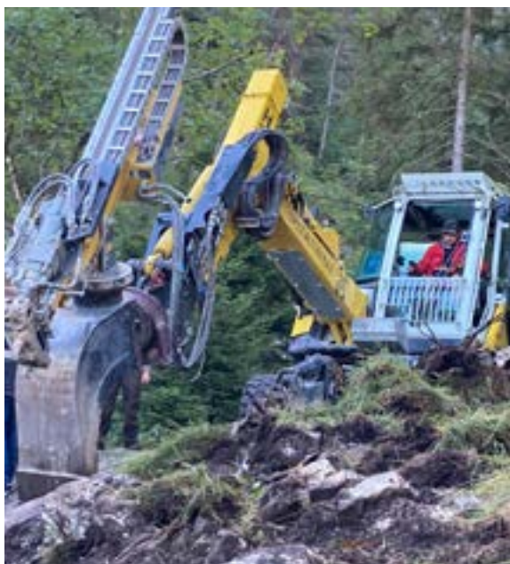
Die Bauarbeiten auf dem Weg zu den Kuhfluchtwasserfällen haben begonnen.
